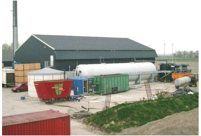
De hydrolyse silo en de liggende reactor. Achter de reactor de WKK. Niet op de foto de navergister en de digestaatopslag.
