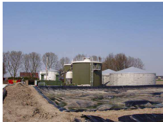
Op de voorgrond het foliebassin, rechts de 2 navergisters
