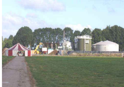
De installatie op de dag van inbedrijfstelling
