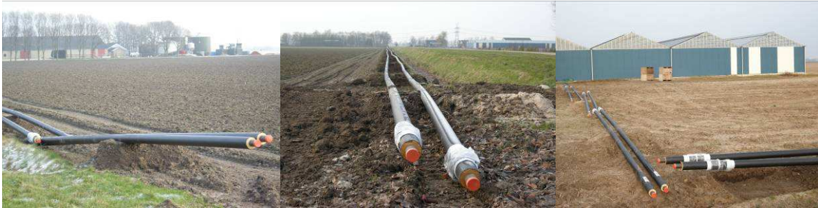
De warmwaterbuizen van de biogasinstallatie naar het buurbedrijf (verwarming kassen)
