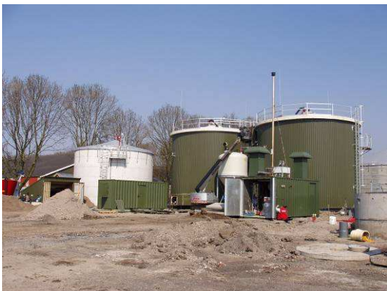
De installatie nadert zijn voltooiing, links de hydrolyse
