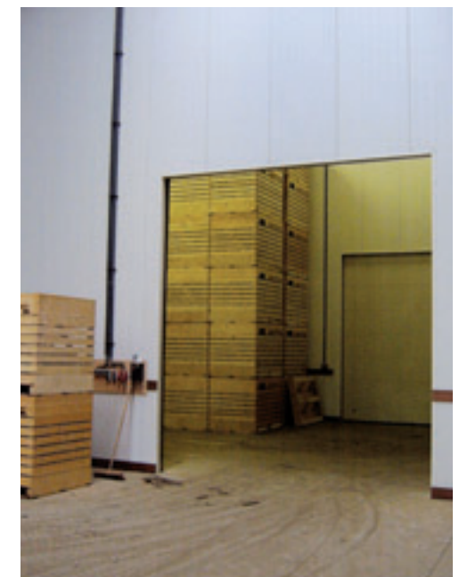
Daar waar deuren zijn, kan niets staan.
