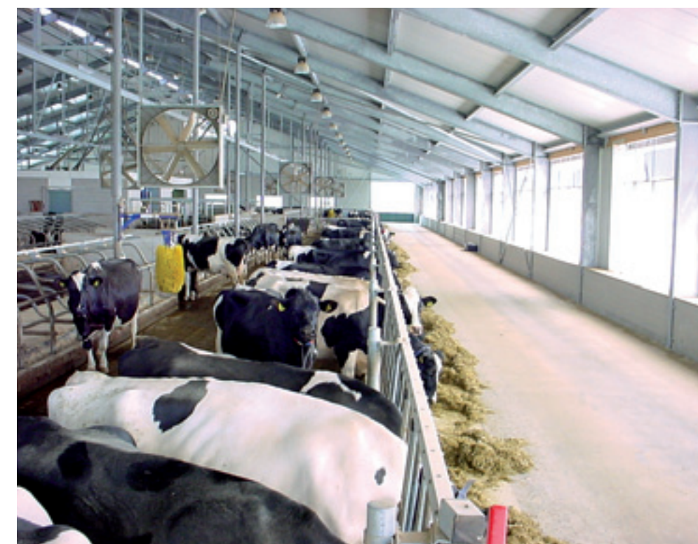
Een stal met veel aandacht voor hittestress: een ruime luchtinlaat, geïsoleerd dak en ventilatoren voor extra luchtbeweging.
