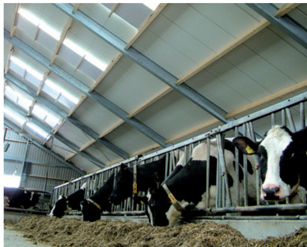
Schuivende panelen voor de lichtplaten houden directe instraling tegen.
