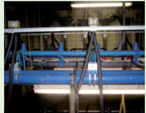
De melkstal op het Lagekostenbedrijf werd zo aangepast dat er met een 48 kPa vacuüm gemolken kon worden. Daarvoor zijn 3 kg zware Dairymaster melkstellen geïnstalleerd. De melk gaat vervolgens omhoog waar het wordt opgevangen in een klein reservoir (rechts). Daarna gaat de melk weer de laagliggende melkleidingen in.
