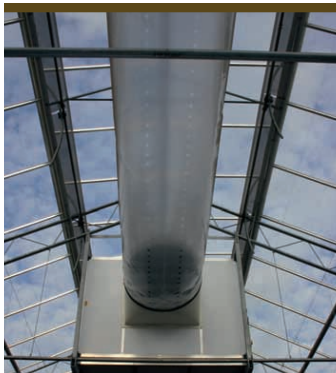
De luchtbehandelingskast en de luchtslang in de nok zorgen voor een gelijkmatige temperatuurverdeling.
