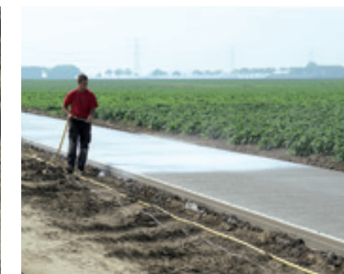
▲ Het beton mag niet uitdrogen. Het wordt daarvoor met curing compound bespoten.
