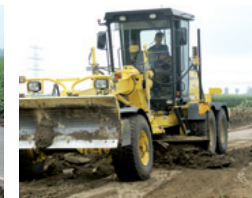
▲ Voor het storten van het pad wordt de ondergrond vlak geschoven.
