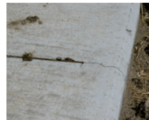
▲ Een zaagsnede zorgt ervoor dat de krimpseur op de juiste plek komt.
