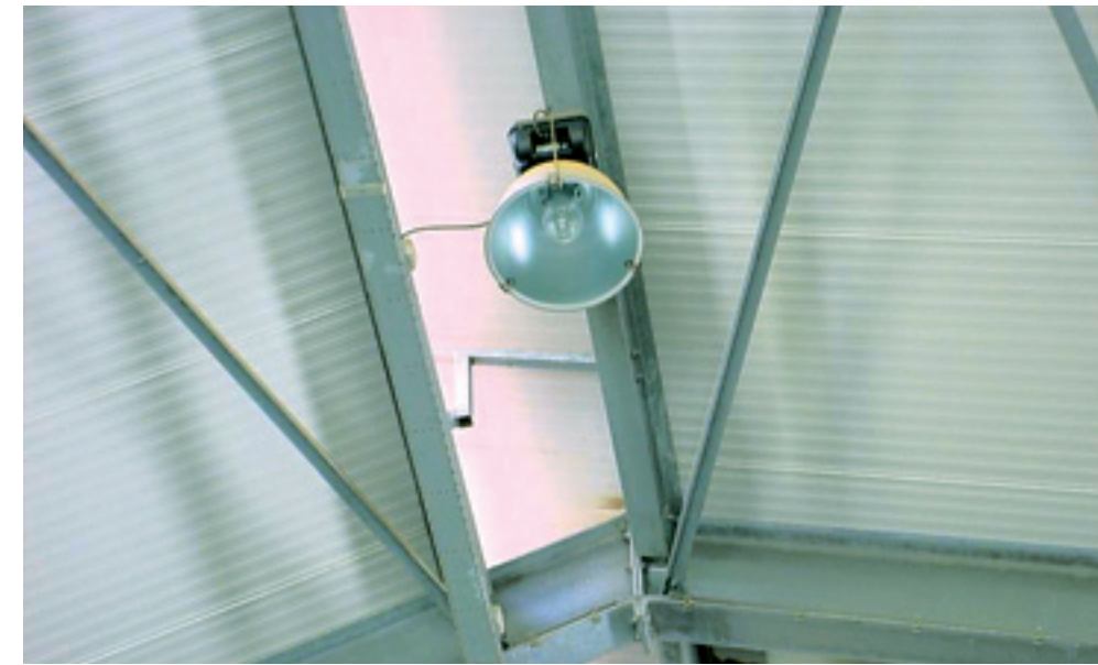
Een gasontladingslamp met industrie-armatuur in nok van de stal zorgt voor een goede lichtverdeling.
