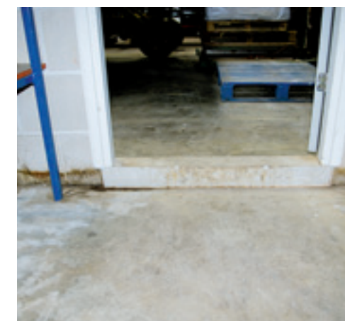
▲ Met een hoge dorpel kan de gehele opslag van gewasbeschermingsmiddelen als lekbak functioneren.
