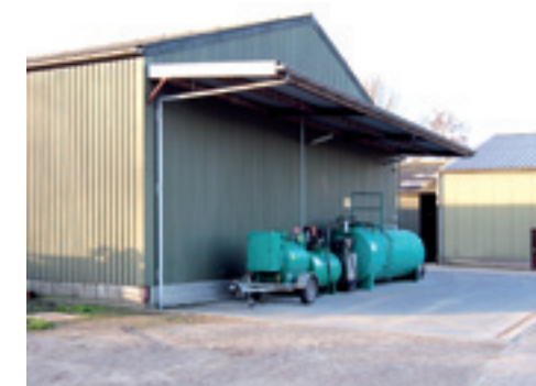
▲ Goed afgeschermd tegen neerslag, onder een afdak.
