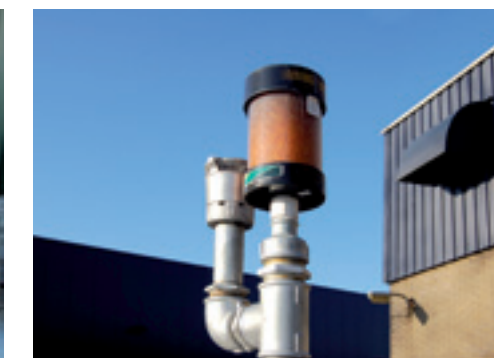
▲ De grijze buis is de uitlaatklep voor warme uitgezette lucht. Als 's avonds de tank afkoelt, komt door onderdruk lucht binnen via het luchtfilter.
