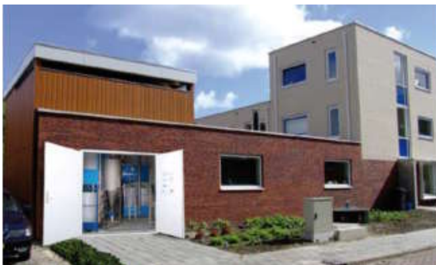
Figuur 2: Collectieve voorziening in Sneek: kelder en garage met installaties voor decentrale waterzuivering en winning van energie en meststoffen. Bron: www.landustrie.nl
