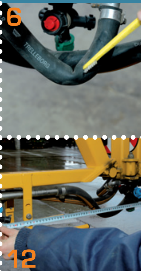
6 Tot slot moet je de afstand tussen de spuitdoppen van het nieuwe deel en het bestaande deel afstellen. Is alles op de gewenste afstand dan kan je de leiding vastzetten en de aanvoerslangen weer opbinden. LM
