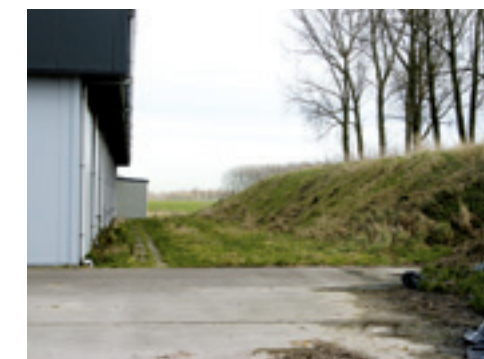
▲ De inlaatluiken zijn onder een overstek geplaatst. Een niet-verharde ondergrond recht onder de overstek absorbeert het geluid zodanig dat er geen of weinig geluid wordt verspreid. Een geluidswal aan de bebouwde kant van de bewaarloods vangt het resterende geluid op.
