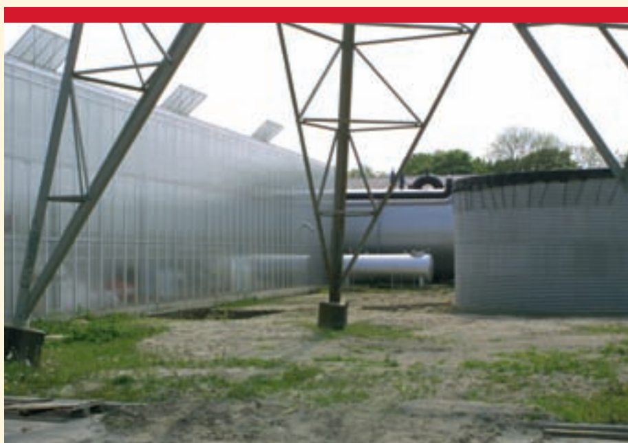
Naast de bedrijfsruimte is plaats vrijgehouden voor een transformatorhuisje en een extra WOK.
