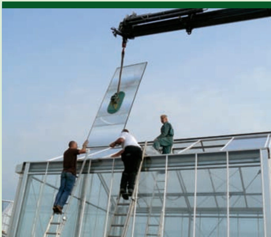
In de proefkas met de Fresnellens zit de lens in vier ruiten dubbel glas van 1 x 3 meter.
