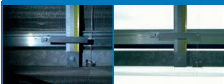
Uit metingen bleek een scherm een kier van 2 cm te hebben. Volgens de klimaatcomputer lag het scherm echter dicht. Dit bewijst dat napulsen geen overbodige luxe is. Meting is om 23.30 uur (foto links) en meting volgende ochtend om 7.00 uur (rechts). Foto's: Ridder Drive Systems
