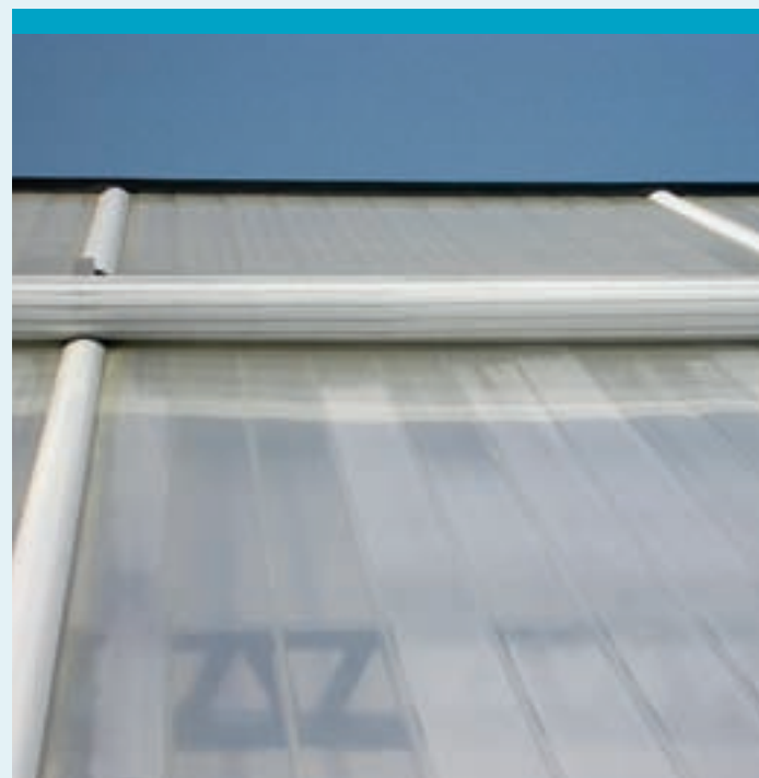
Rolschermen op breedkappers worden meestal gemonteerd aan de onderkant van de luchtraamopening en rollen van daar tot aan de goot. Het luchtraam kan dus normaal open.
