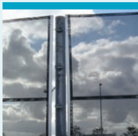
In Europoort staat een 2 km lang (anti-)stofschermbaan van een luchtdoorlatend materiaal. De berekening van dit soort constructies is ook toepasbaar op buitenschermen.
