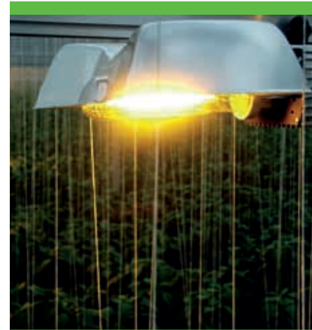
Het grootste deel van de warmtestraling van de reflector valt op het gewas recht onder de lampen.
