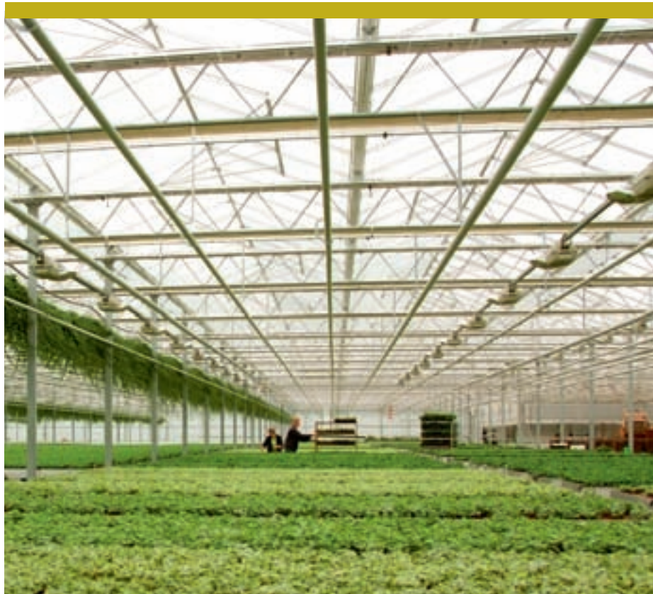
De nieuwe Venlo-kas heeft 3 kappen per tralie van 12,80 m. Dat scheelt één goot per tralie en zorgt dus voor meer licht in de kas.
