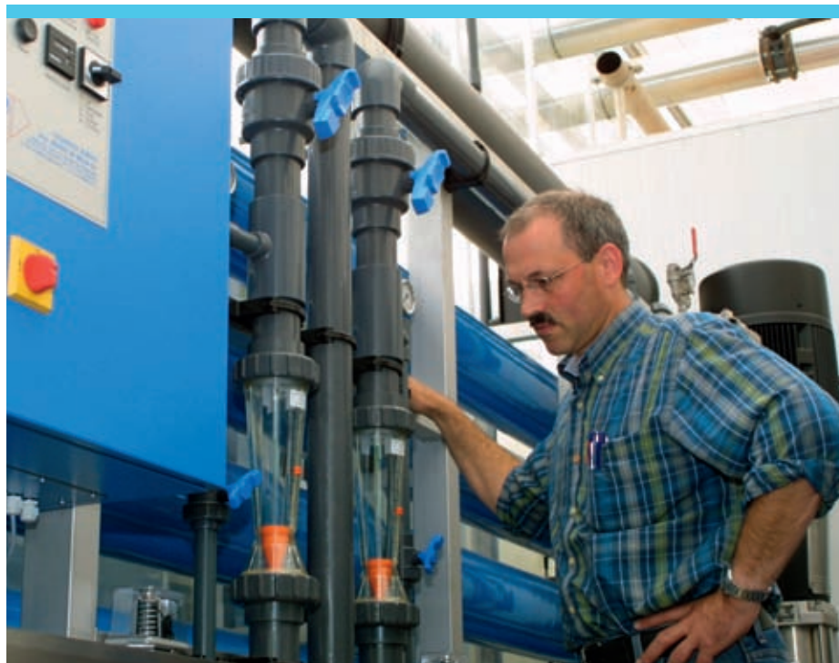
Martien Melissant: "Om verzekerd te zijn van goed uitgangswater schakelen veel telers over op osmosewater."
