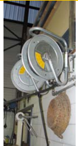
Gemakkelijk olietappen dankzij rondgaande olieleiding met verschillende tappunten.
