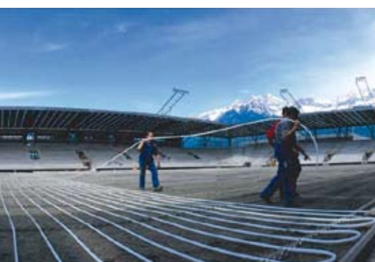
Aanleg watersysteem Rehau
