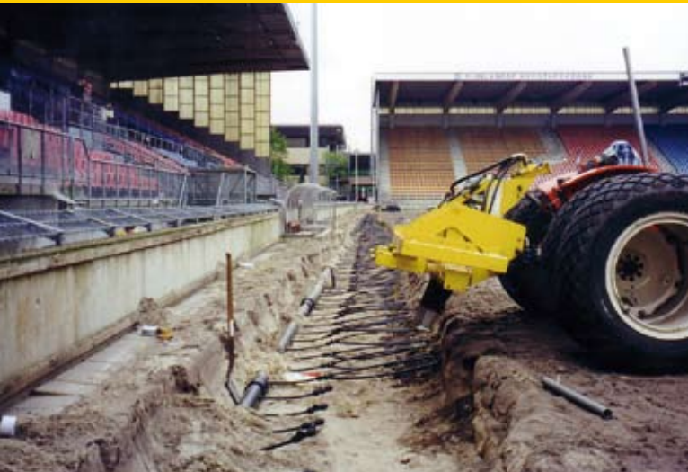
Aanleg watersysteem van Verbakel-Bomkas
