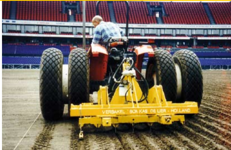
Steeds om de 25 centimeter een slang
