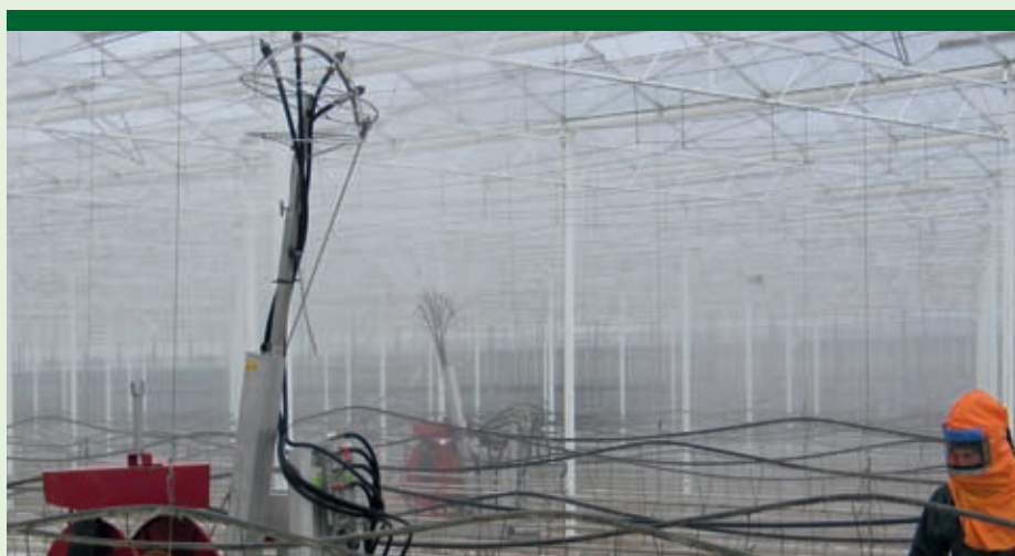
HPW Spuittechnieken gebruikt een druk van 70 bar en veel water bij het afsputten van de binnenkant om er zeker van te zijn dat ook het ergste vuil van het glas gaat. (foto: HPW)
