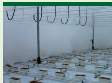
Sinds kort beschikt Van der Marel's loonbedrijf over een Maxi-fogger. Met deze fogger zijn de gevels ook bij een kaplengte van 125 meter goed bereikbaar. (foto: Van der Marel)
