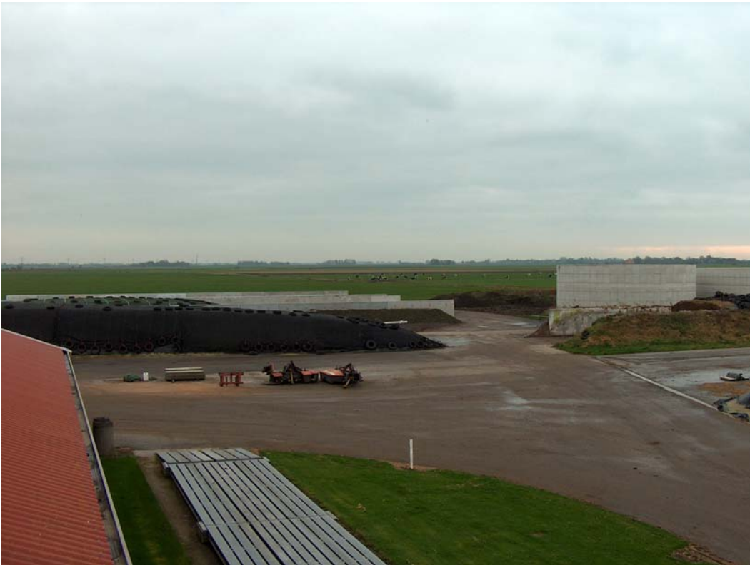
Een blik op de nieuwe sleufsilos en de nieuwe silo's voor de mestvergisters. Leuk detail: in de verte loopt nog wel wat jongvee in de wei.
