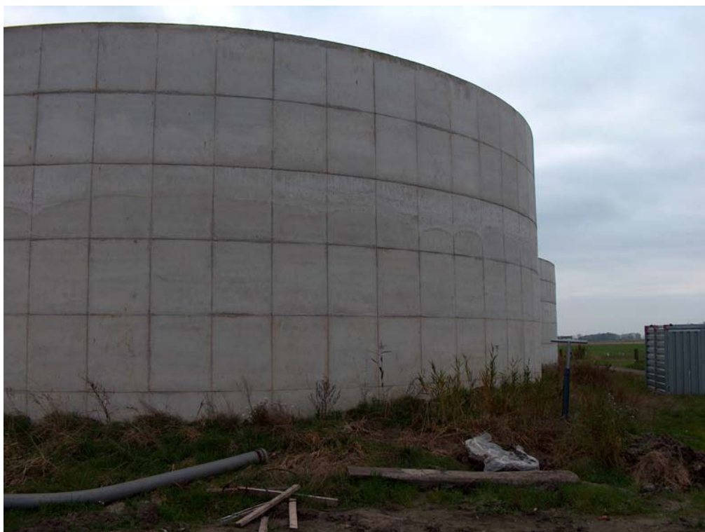
De nieuwe mestvergisters in aanbouw: deze gaan ook een woonwijk verwarmen.
