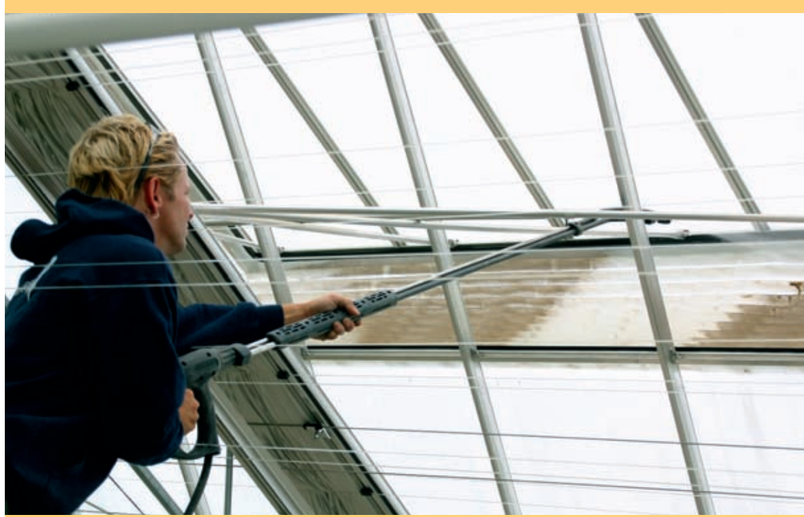
Een ervaren medewerker van Holland Gaas kan met de beweegbare kop van de spuitlans ook de moeilijk bereikbare plaatsen van het gaas goed schoon spuiten.
