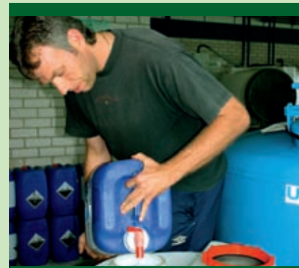
Mark Zwinkels vult een vaatje met Hyperclean. Een injectie-/doseerpompje brengt het middel direct in de aanvoerleiding van het druppelwater of in de mengbak.
