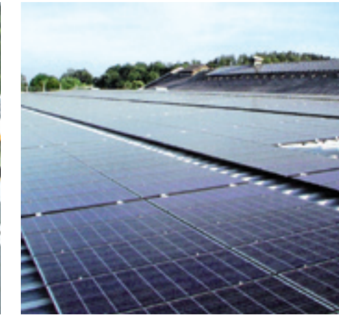
▲ De constructie van het gebouw moet wel geschikt zijn voor een dak vol zonnepanelen.
