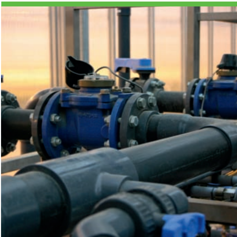
Watermeters hebben een diameter van 15 tot 300 mm. Om goed te kunnen meten zijn bepaalde inbouwmaten van belang. Bovendien moet de leiding altijd vol met water zijn en mag geen lucht bevatten.
