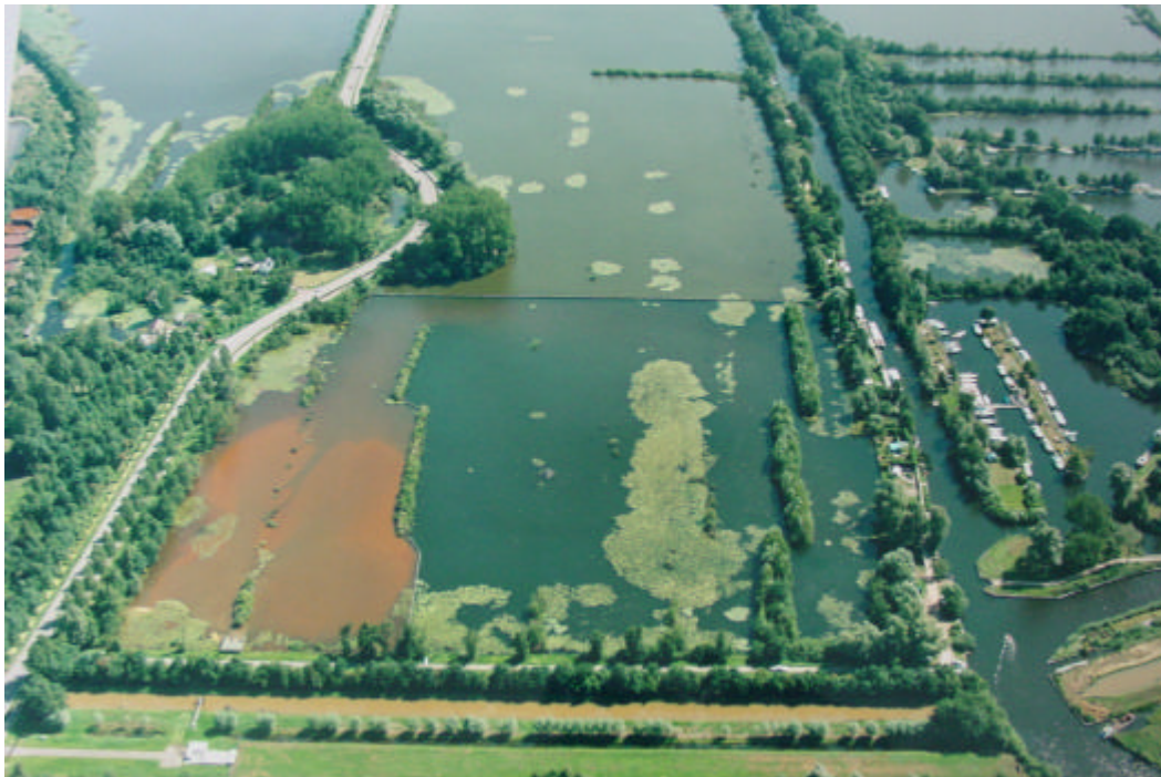
Inlaatpunt gedefosfateerd Amsterdam-Rijnkanaalwater ten behoeve van peilbeheer van het Loosdrechtse Plassengebied
