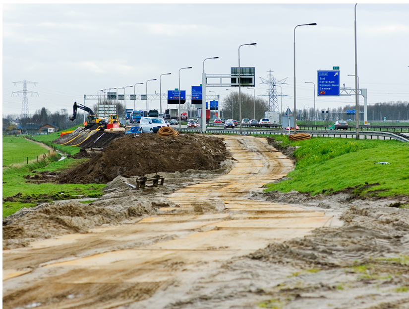
Afbeelding 3.2.2: Rijksweg A50, aanvoer grond voor het grondlichaam
