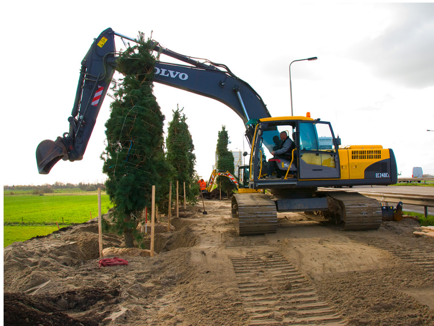
Afbeelding 3.2.3: De naaldbomen worden met kraan in het plantvak geplaatst
