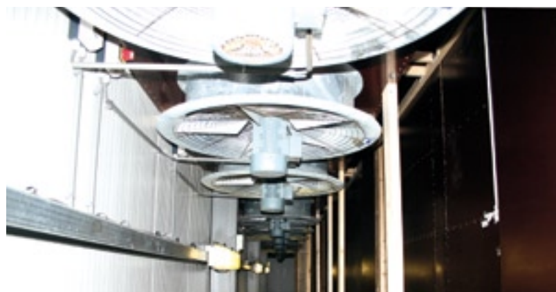
Twaalf ventilatoren zorgen bij Van der Heijden voor de onderdruk.
