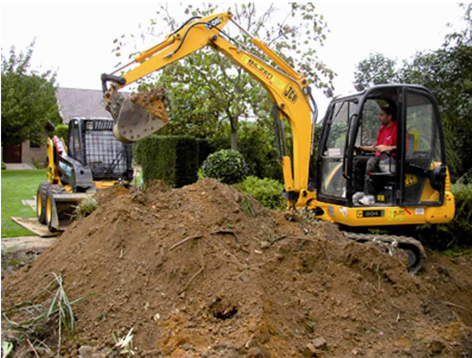
Figuur 4.1: Voor grond afvoeren is een vergunning nodig (bron: www.steegske.be/afbeeldingen/vijver/werkfoto/graven1.jpg ).
