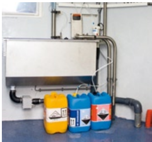
De spoelautomaat voegt automatisch de juiste hoeveelheid reinigingsmiddelen toe.
