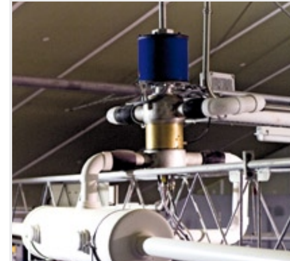
Het draaipunt van de leidingen bevindt zich op de brug.
