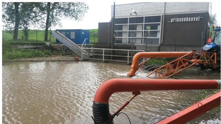
Figuur 17: Noodbemaling Prinsenheuvel
