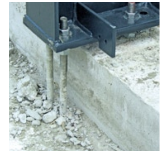
▲ Ankers horen in de balk en niet ernaast.
