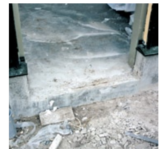
▲ Soms is sloopwerk onvermijdelijk als bijvoorbeeld een betonpaneel helemaal doorloopt.
