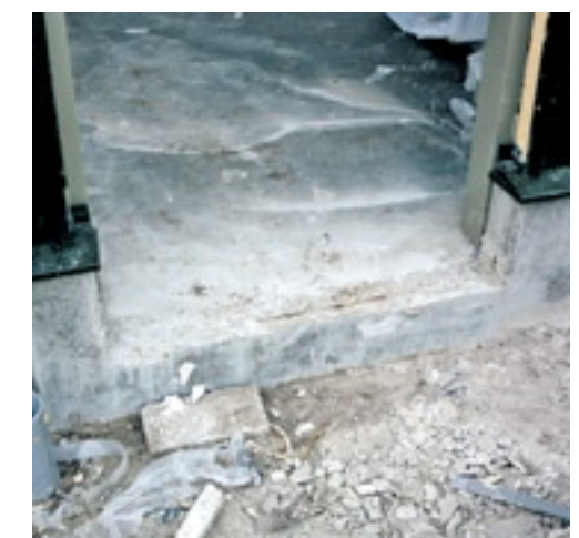
▲ Soms is sloopwerk onvermijdelijk als bijvoorbeeld een betonpaneel helemaal doorloopt.
