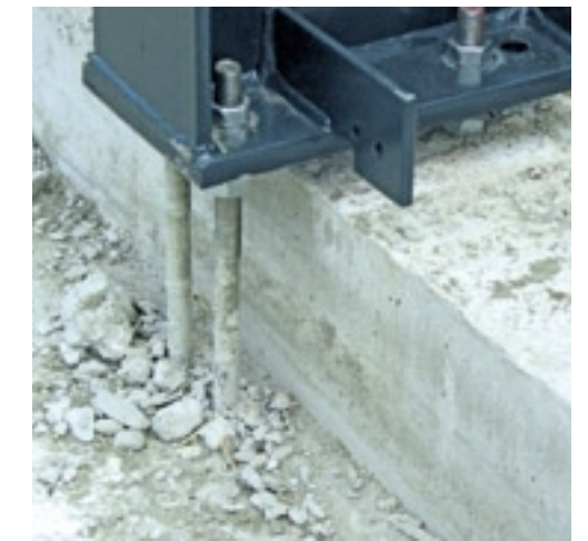
▲ Ankers horen in de balk en niet ernaast.
