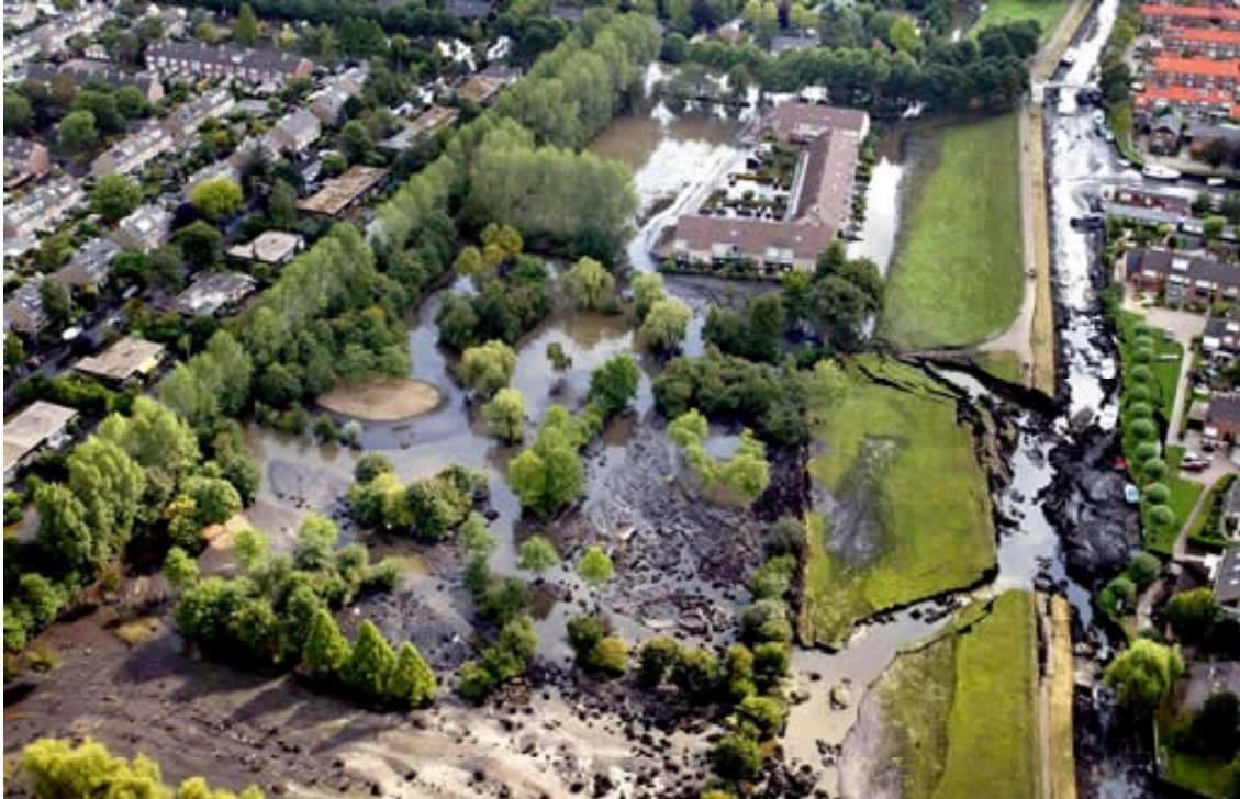
Afbeelding 12: Kade-doorbraak bij Wilnis. Rechts op de foto is de watergang te zien die nagenoeg volledig is leeggelopen
