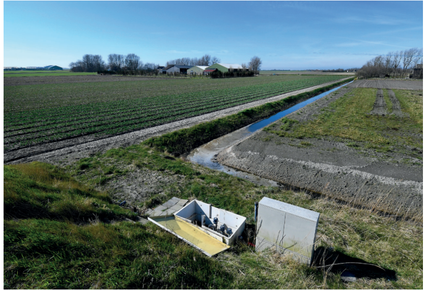
De bollenkweker gebruikt het systeem alleen nog om het waterpeil in het perceel op te zetten.
