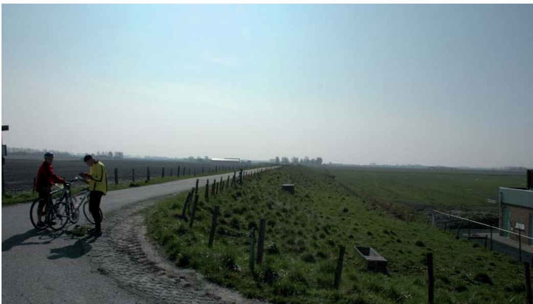
Regionale waterkeringen op Schouwen-Duiveland
