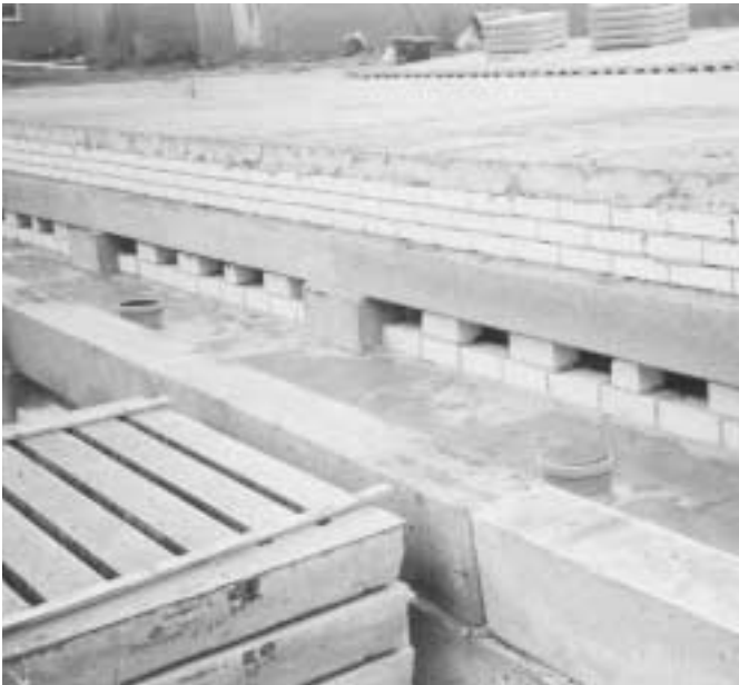
Gemetselde luchtinlaatopeningen in de draagmuur van de ligvloer
