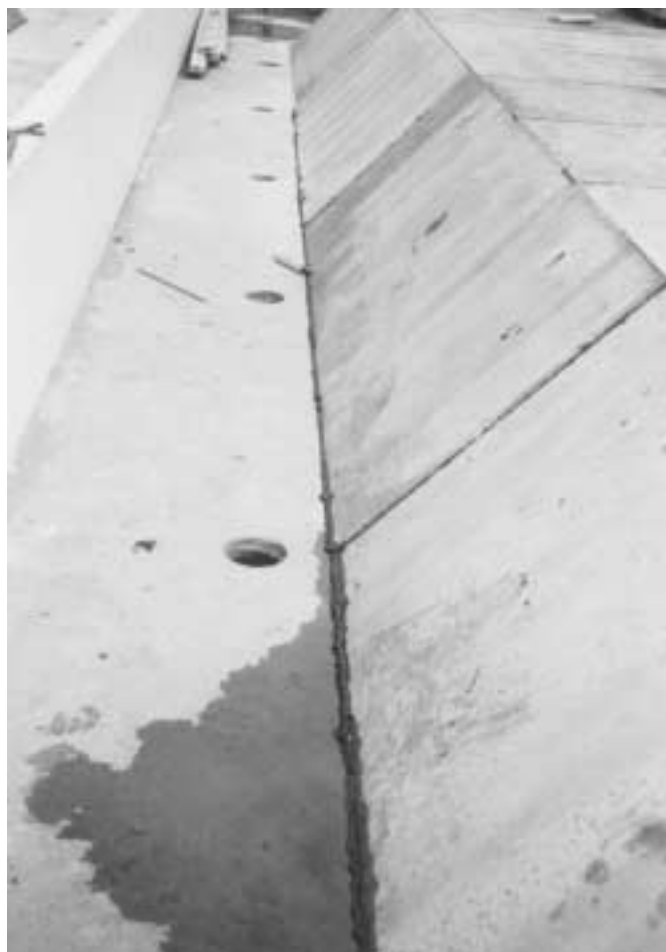
Prefab betonnen schuine kelderwanden tegen de ligvloer
