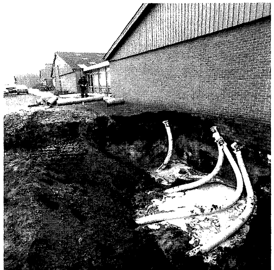
De aanleg van grondbuisventilatie bij de eerste proef.
