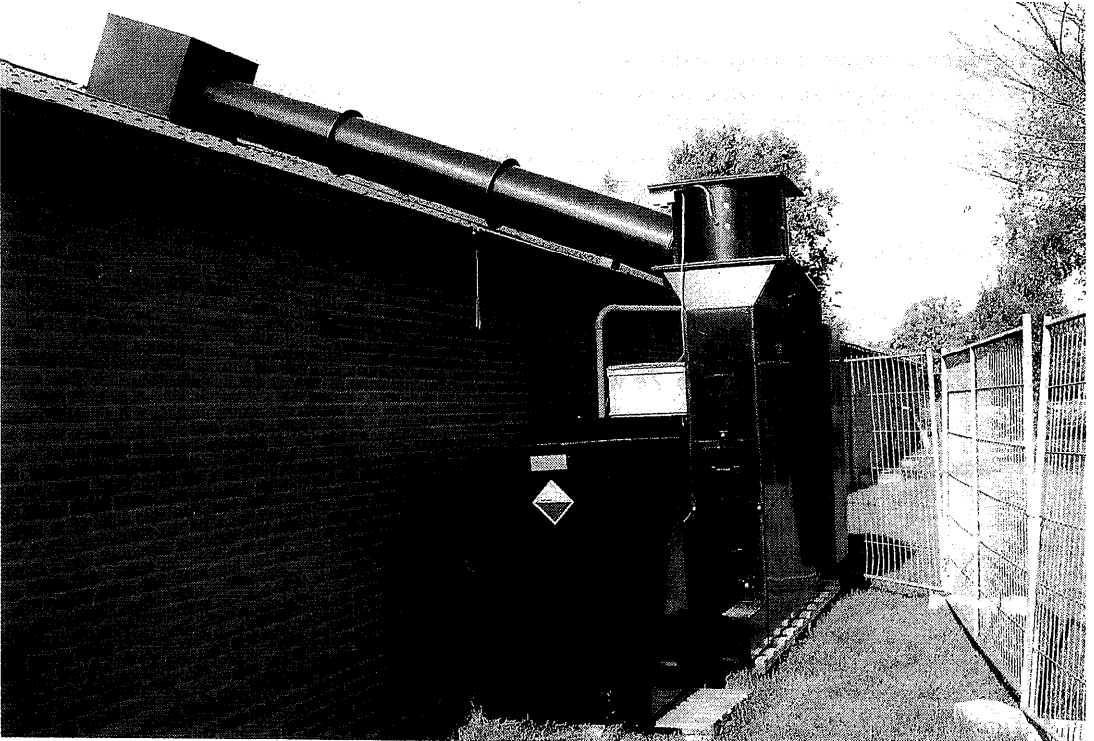
De chemische luchtwasser naast de vleesvarkensstal
