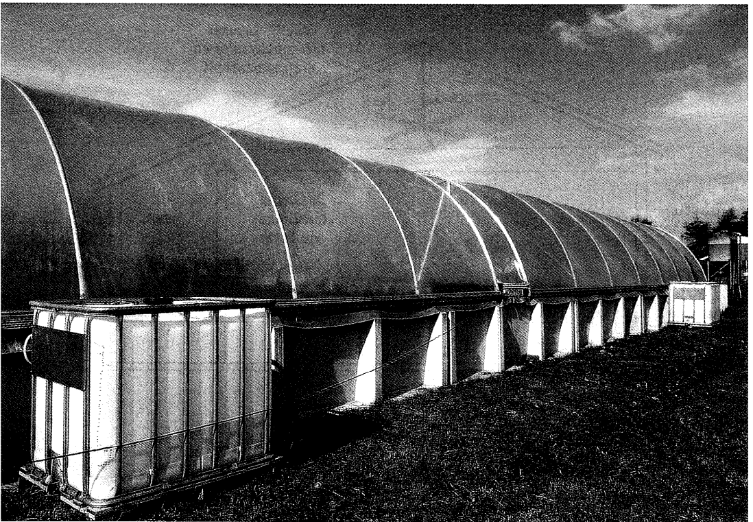
Mestbassin met overkapping van lichtdoorlatende foliekas
