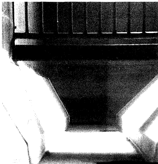
Foto 4: Schuine plaat in de put
