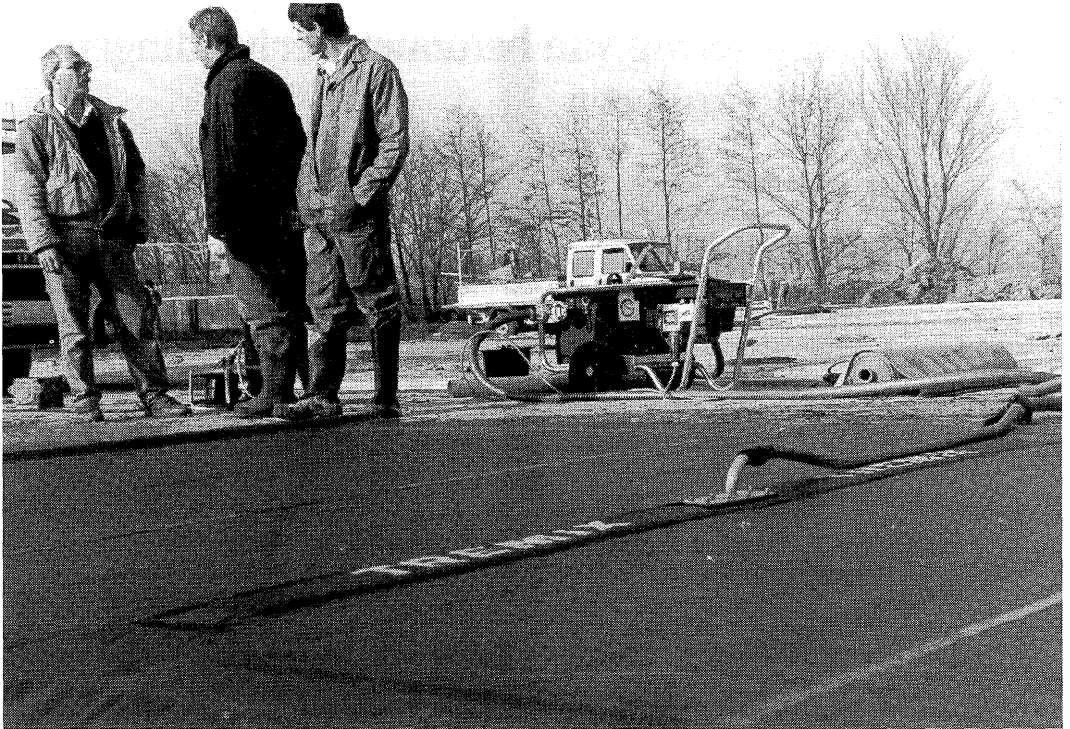
Met de vacuüm methode wordt water uit het beton gezogen', via een slang loopt dit water weg.
