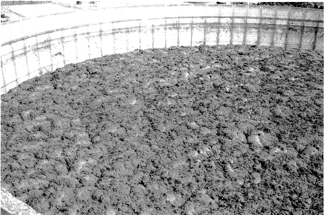
Bij het denitrificatieproces verdween de stikstof en kwam schuim naar boven.
