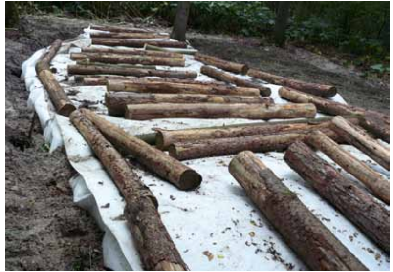
De proefvakken met een monocultuur met Sachalinse duizendknoop zijn voorzien van middelzwaar geotextiel dat is uitgerold en vastgelegd met boomstammen.
