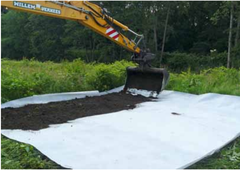
Het geotextiel kan worden vastgelegd met een laag van 20 cm grond.
