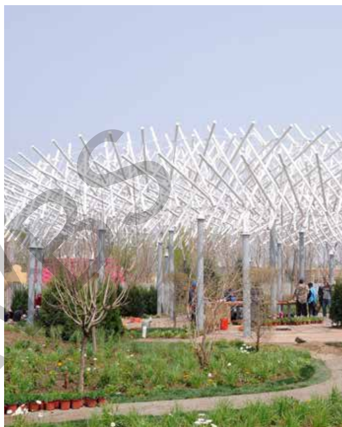
Het Belgisch paviljoen in Beijing in opbouw. Naast streekeigen beplanting komt ook Belgische beplanting aan bod.
