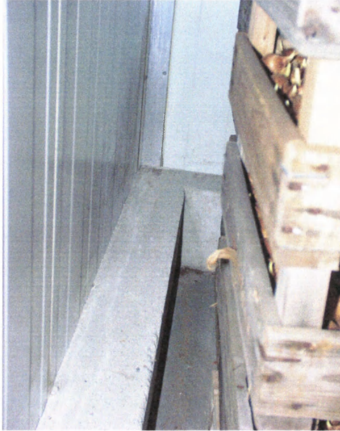
Fig. 9, grondbalk garandeert luchtbeweging tussen product en wand.
