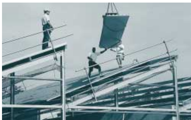
Het High-techbedrijf heeft een zaagtanddak met geïsoleerde dakplaten.
