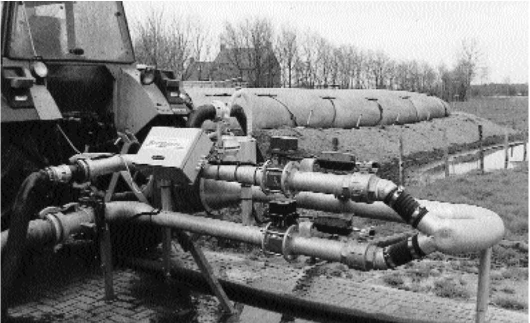
De mest en het water worden door aparte leidingen aangevoerd. Het meet- en regelsysteem op de pomp verdunt de mest in een constante verhouding van één deel mest op drie delen water .
