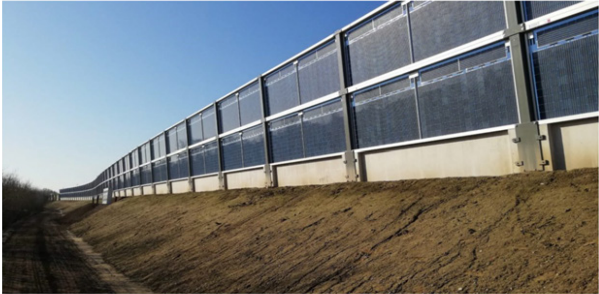
Figuur 5 Bifaciale panelen langs de A50 bij Uden, geluidswal en zonne-energie gecombineerd. Foto: Solar Energy Application Centre (Bron: PV Magazine 20/2/2019).
